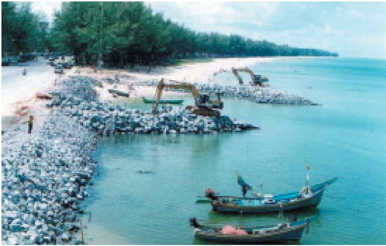
ระยะที่สี่ : เริ่มก่อสร้างเขื่อนกันคลื่นรูปตัว T บนหาดแก้วเสด็จ ปี 2545 ที่มา : เครือข่ายเฝ้าระวังรักษาชายหาด
